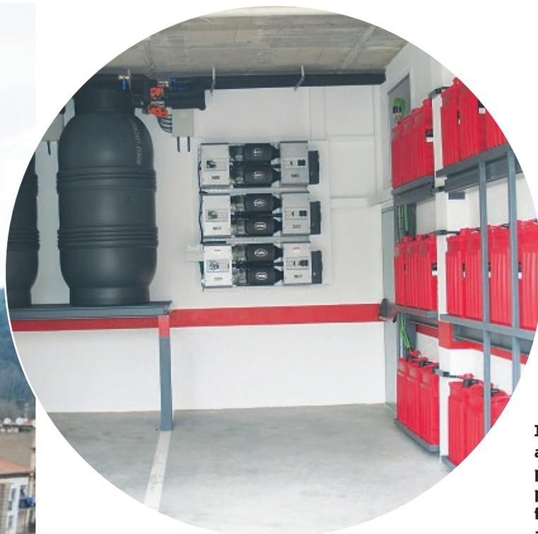
**Imagen de la sala de acumulación con las pilas de combustible para las placas fotovoltaicas y las de agua de la geotermia**
